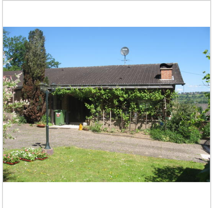
Ansicht mit Veranda (süd)
